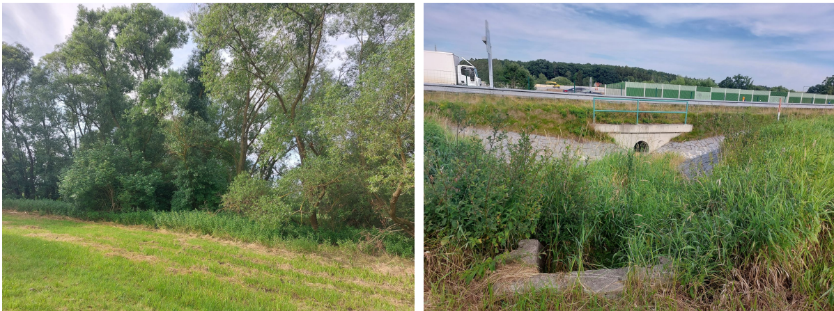
Obrázek č. 13 a 14: Vegetace podél bezejmenné vodoteče a propustku, foto B. Janíčková
